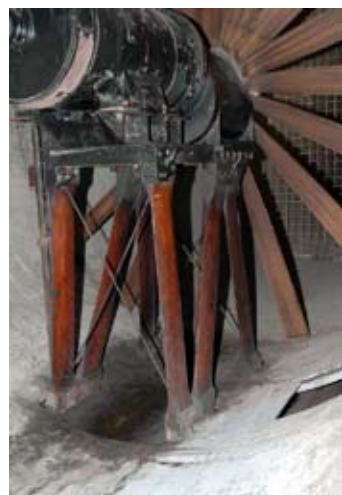
La grande elica lignea, fatta a mano, della galleria di Finale (Foto M. Burnengo, 3/12/2005)
